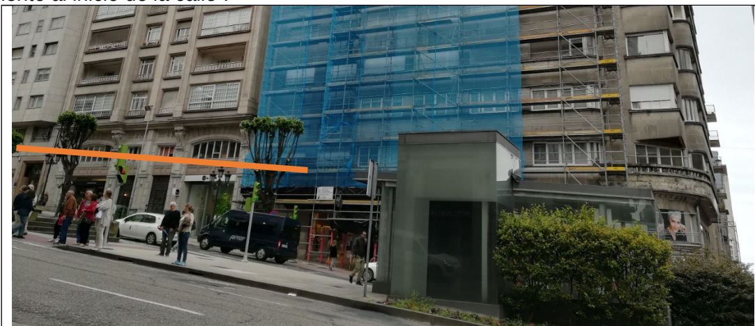
Se señala en naranja aproximadamente la altura de la marquesina.
